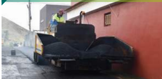
Obras de asfaltado en una calle del municipio
